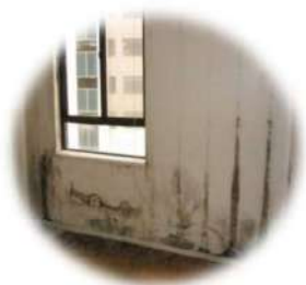
Humidité, température et CO 2
